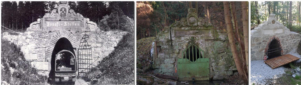
Vstupní portál dědičné štoly Josef – repro Kohoutí kříž 1929 + 2003( F.Z.) + 2015( F.Z.)
