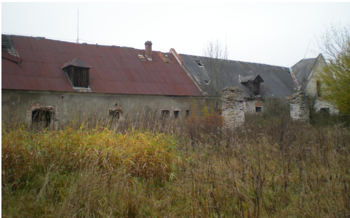
Vnitřní strana levé části objektu - F.Z. 8.11.2011
