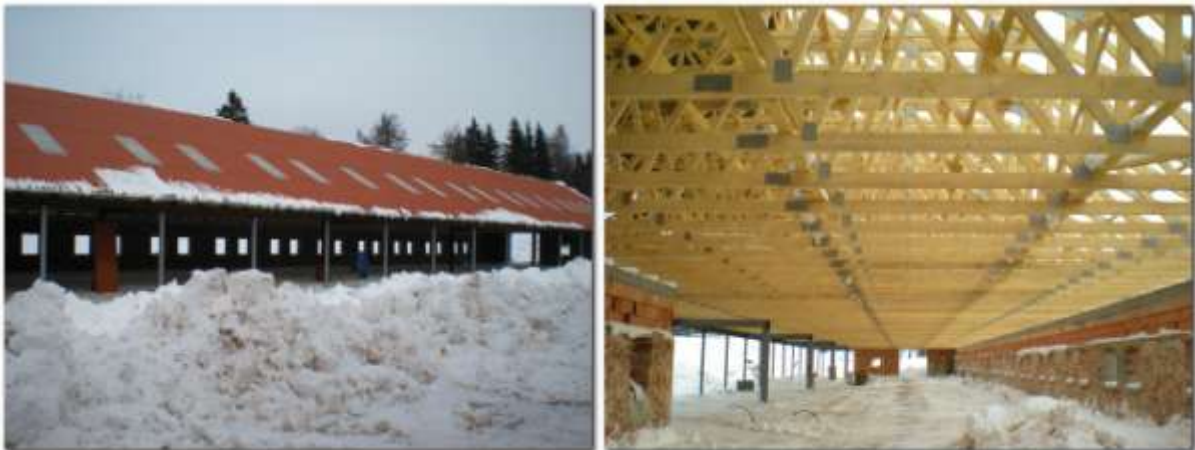
V polovině února 2010 byla na stáji č.1 již nová střecha a na stáji č. 2 krov
