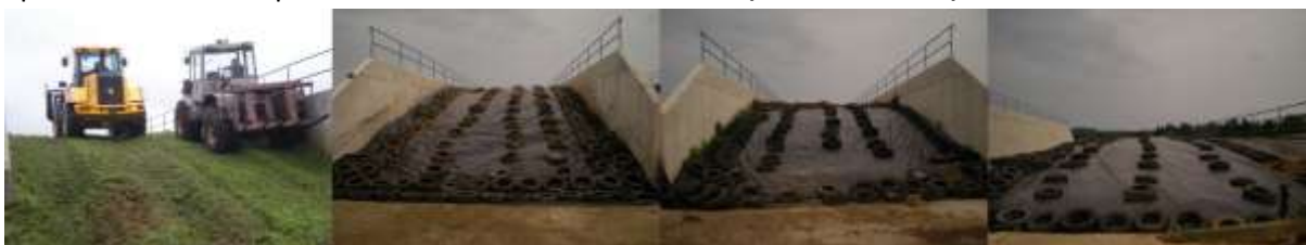
Dusat na jámě pomáhá i ŠT-180 (28.5.2014 – F.Z.) + po skončení se jámy uzavřou (4.7.2014 – F.Z.)
