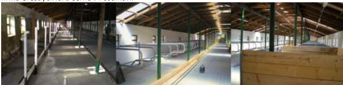
Rekonstrukce kravína – foto zleva: 25.3.2011 + 13.7.2011 + 18.8.2011
