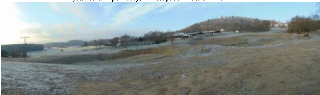
Stavba je ukončena – Foto 10.12.2014 F.Z. – Kolaudace proběhla v polovině prosince 2014
