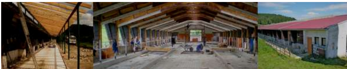
Rekonstrukce odchovny – foto zleva : 23.6.2011 + 26.7.2011 + 18.8.2011
