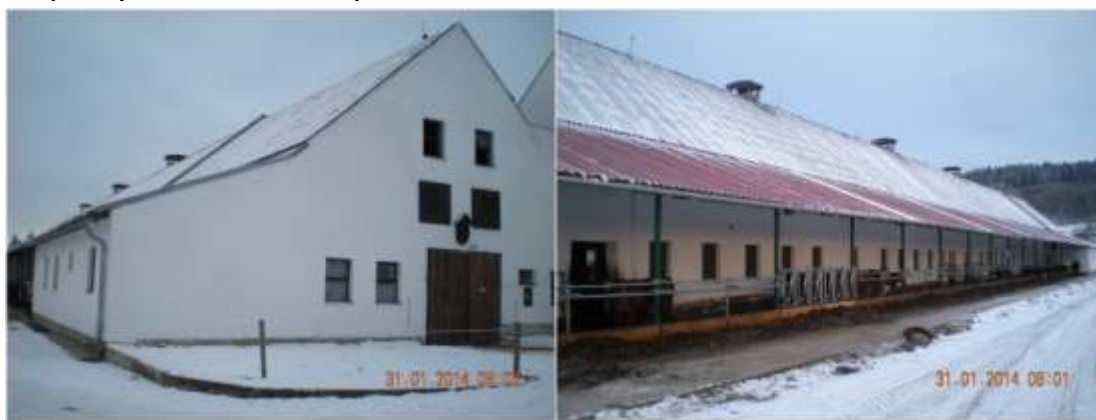
Zrekonstruovaný objekt kravína Muckov 2 jako osmá stáj celého budovaného komplexu
