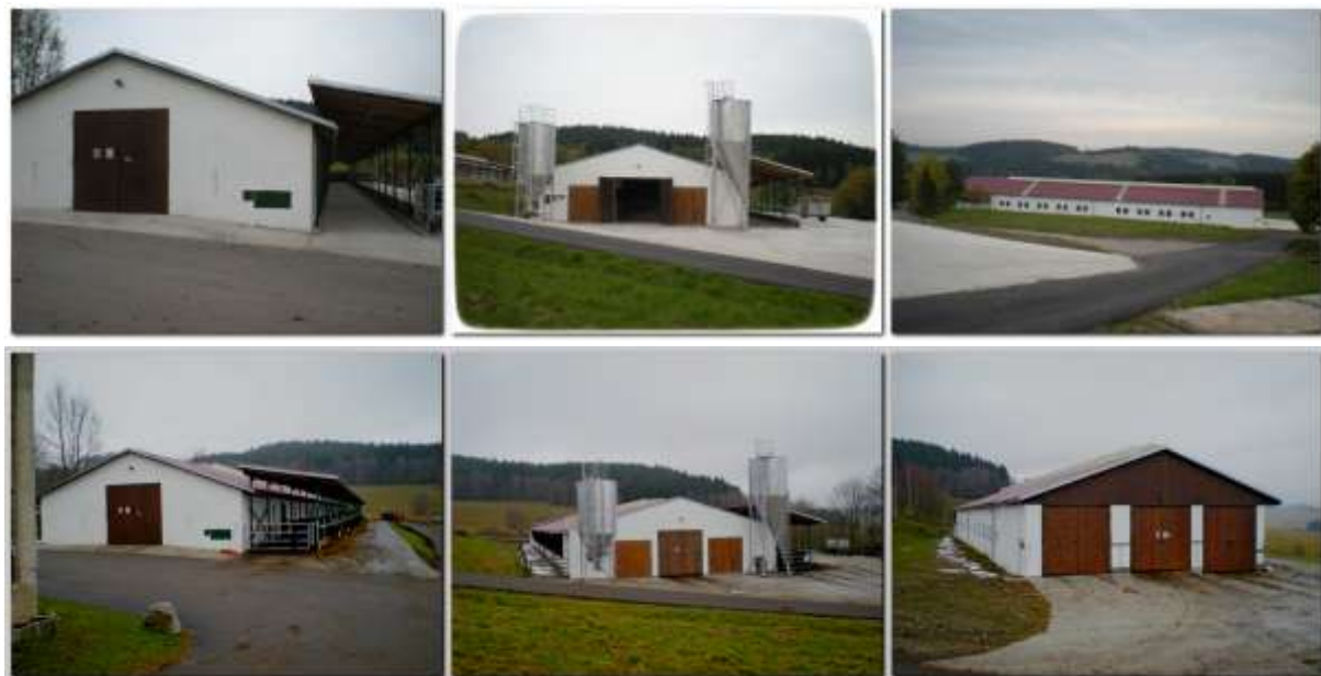
Nově zrekonstruované stáje na Malšíně – Ostrově - dva různé pohledy – foto 19.10.2011
