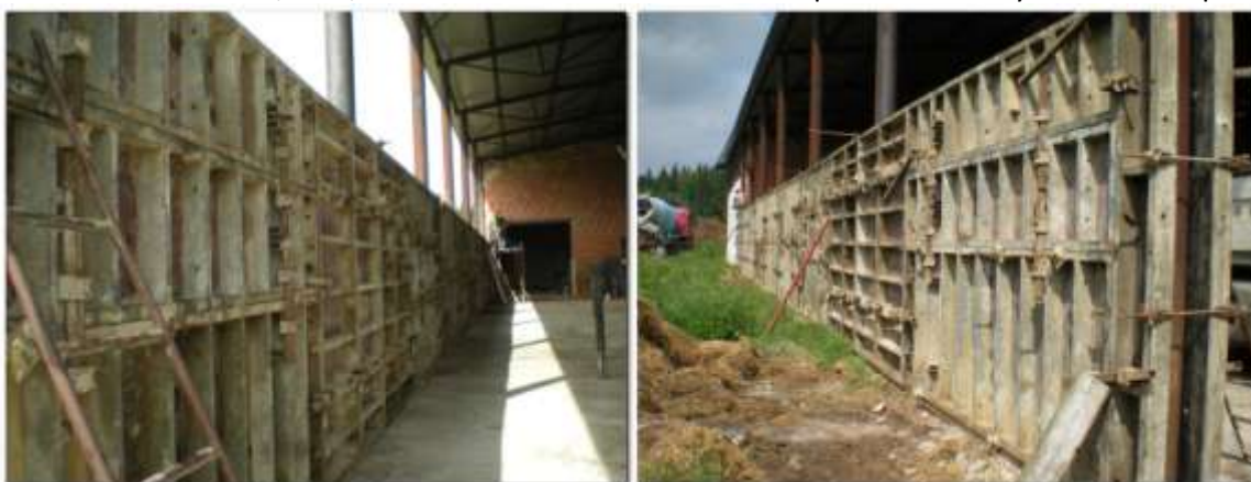
Z původní kolny byly vybourány dřevěné stěny kolem a provedlo se obezdění/12.6.2014/
