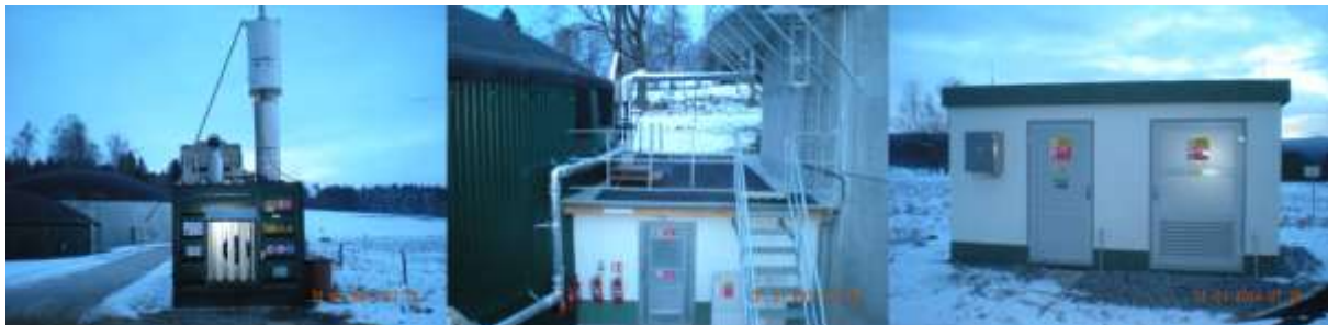
Na obrázcích je zleva: kontejner generační jednotky + strojovna + trafo
