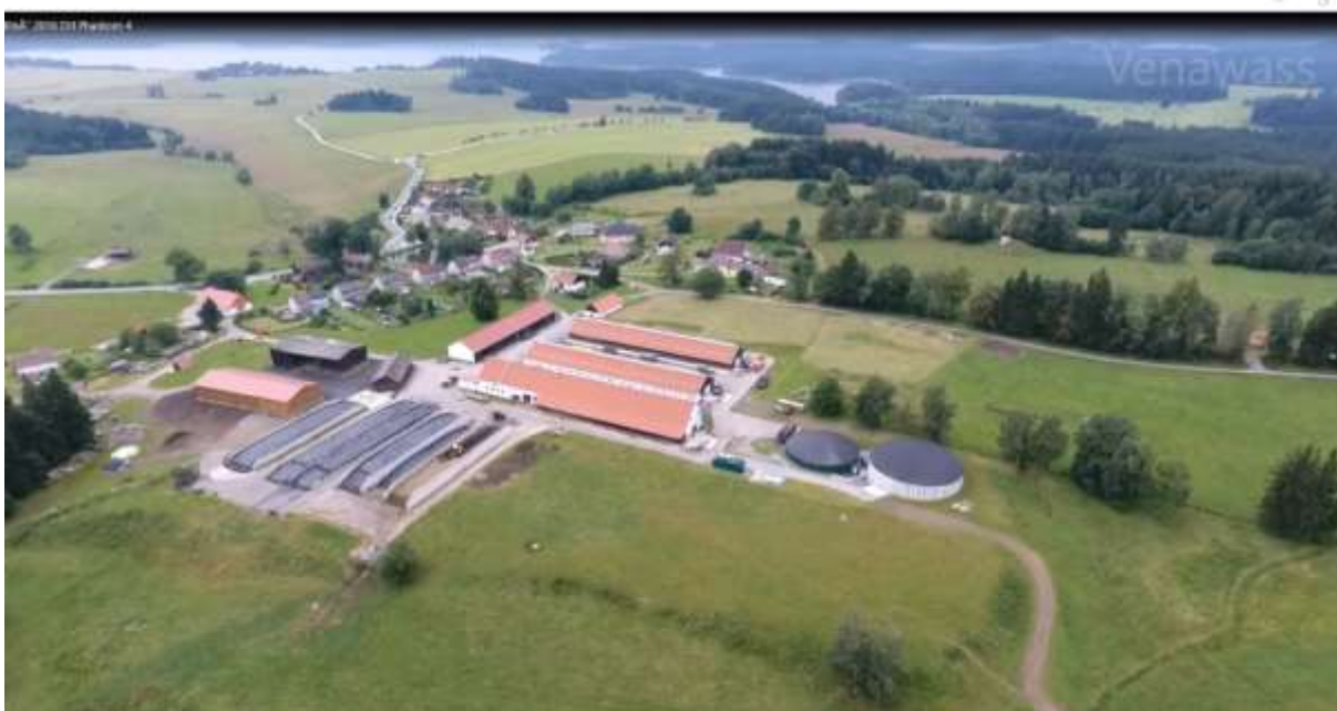
Celkový pohled na farmu Milná po komplexní rekonstrukci objektů spolu s bioplynovou stanicí – letecky zdroj You Tube 2016
