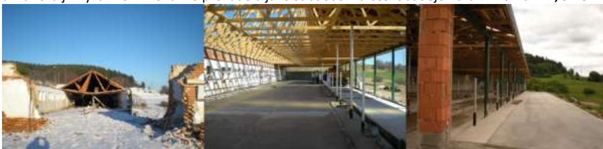
Rekonstrukce teletníku – foto zleva: 29.12.2010 + 7.4.2011 + 23.6.2011
