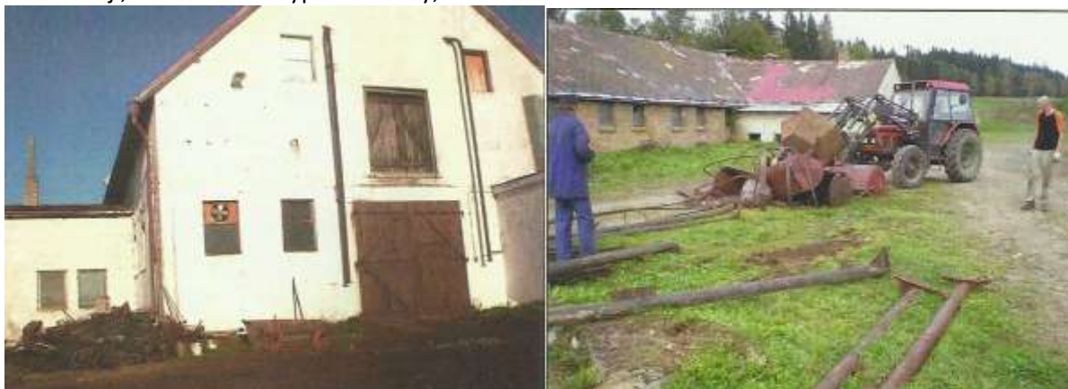
Hlavní vchod do kravína č.1 + likvidace nepotřebného materiálu – listopad 2008 + duben 2009
