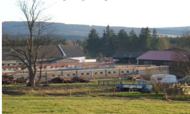
Koncem listopadu 2009 byly postaveny obvodové zdi
