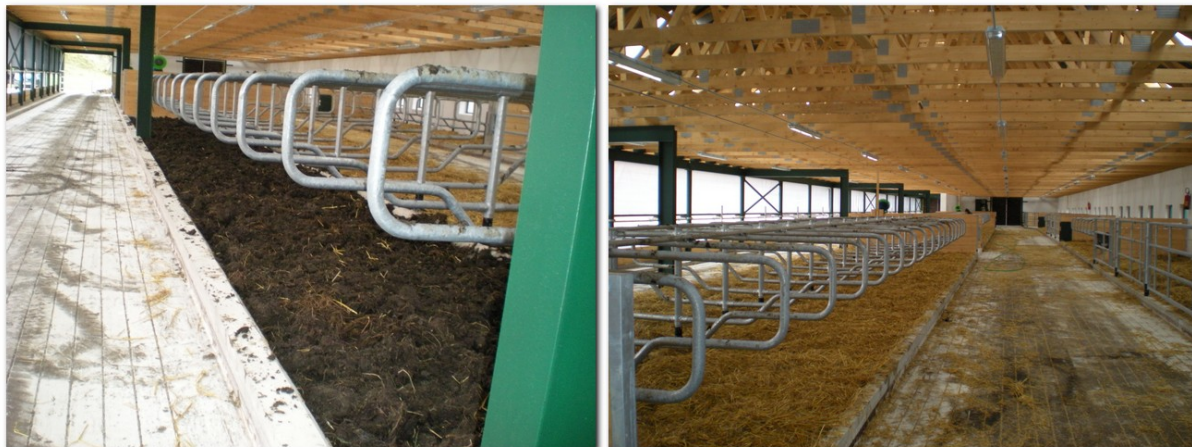
Na ložnou plochu se nejprve rozvrstvil uležený chlévský hnůj, který vytváří tepelnou izolaci Na rozvrstvený hnůj se uložila vrstva slámy
