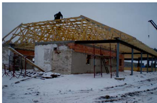
V polovině prosince 2009 se montoval krov
