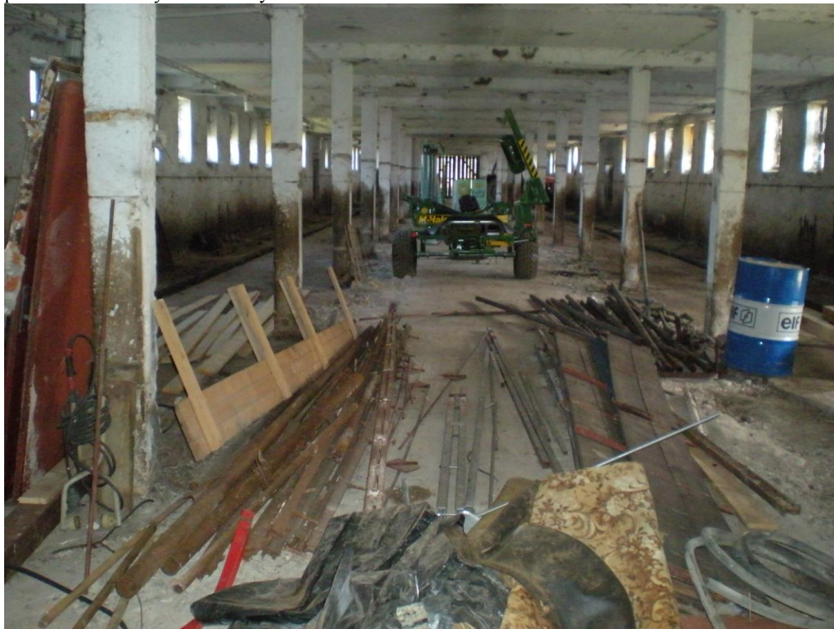
Příprava na rekonstrukci na Milné / foto F.Z./
