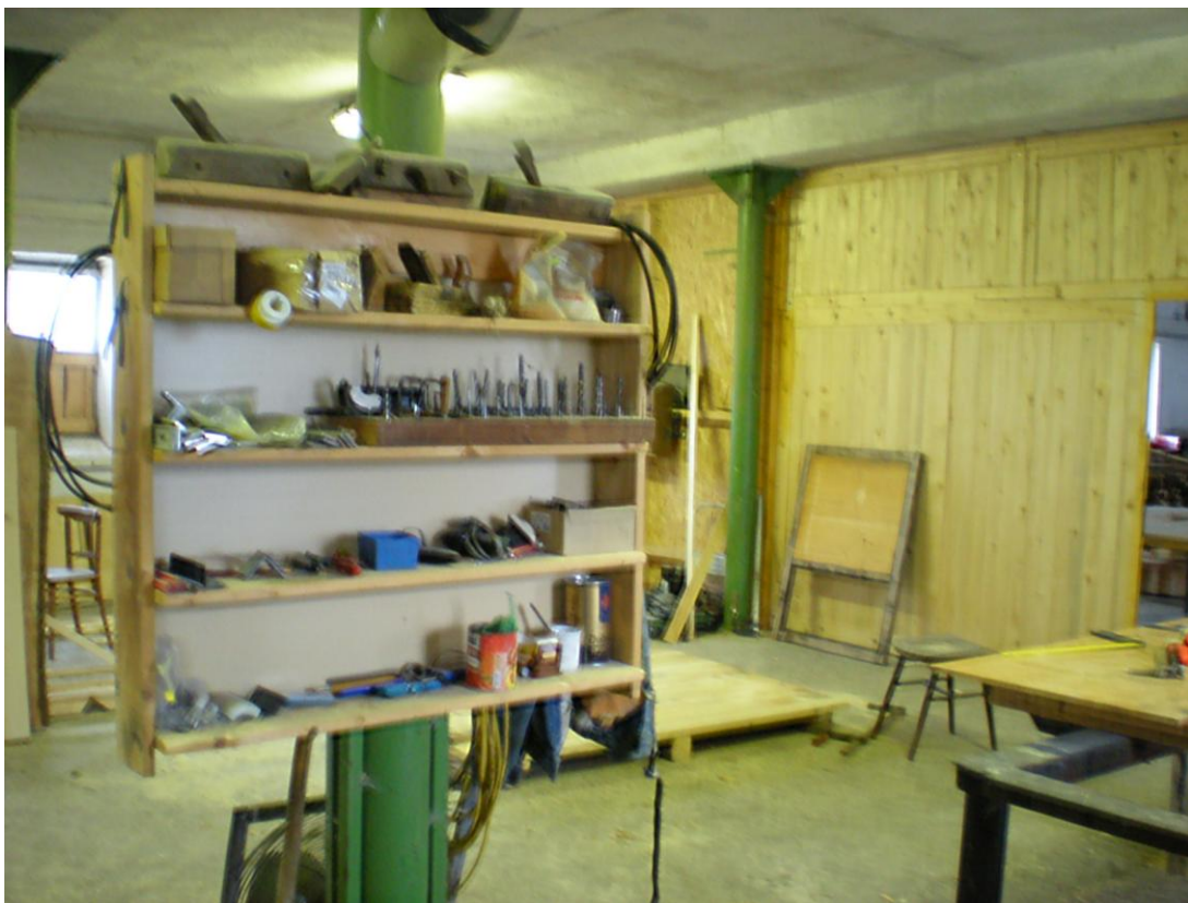
Z jedné části kravína na Muckově firma vybudovala tolik potřebnou truhlářskou dílnu - dva obrázky foto F.Z.
