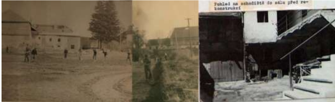
Výstavba hřiště na kopanou v roce 1966 + před adaptací budovy pohostinství
