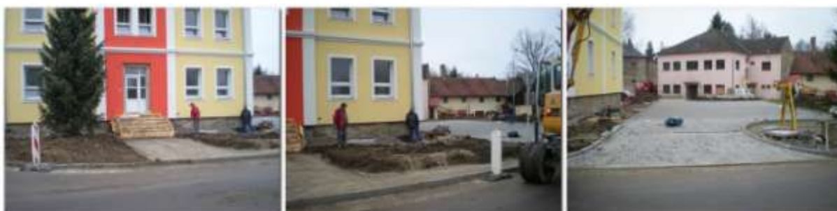
Na snímcích z 23.11.2012 jsou dokončovací práce vstupního prostoru objektu a nově upravené parkoviště pro vozidla budoucích nájemníků – foto F.Z.
