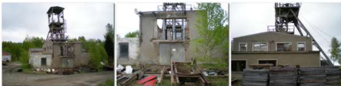
Likvidace těžní věže a ostatních chátrajících budov – 6.5.2009 – F.Z.
