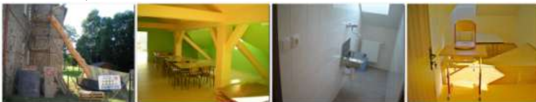
Foto – bourací práce 9.7.2011 + 3x konečná úprava – foto ze 14.10.2011- F.Z.
