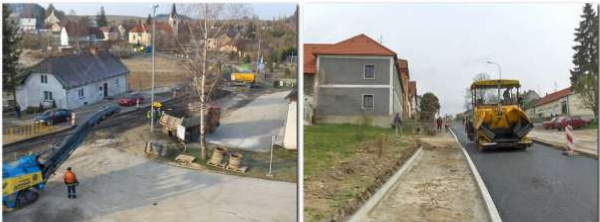
Průběh prací v obci – 27.3.2007 + 4.4.2007
