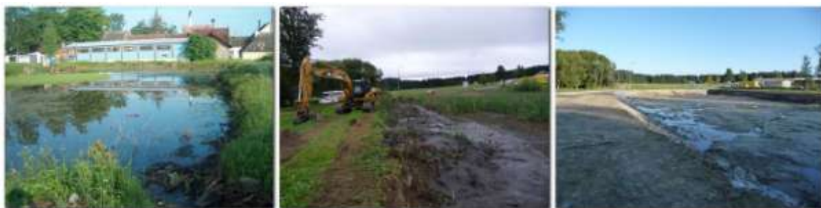
Rybník před rekonstrukcí + vlastní práce + část odbahněného a rekonstruovaného rybníka – foto 2008
