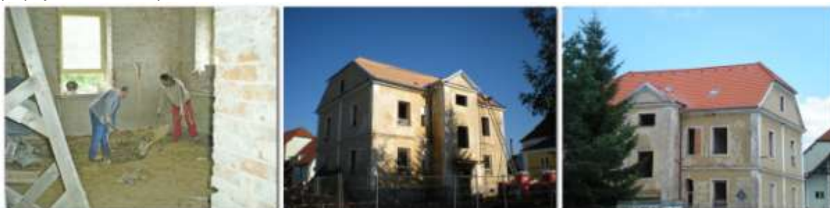
Foto uvnitř 13.6.2012 + stará střecha 3.8.2012 + nová střecha 14.8.2012 – F.Z.
