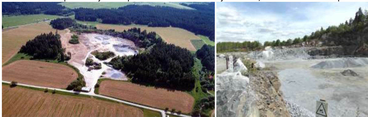
Letecký pohled na prostor Kamenolomu + vnitřek těžební části – 21.5.2016 F.Z.
