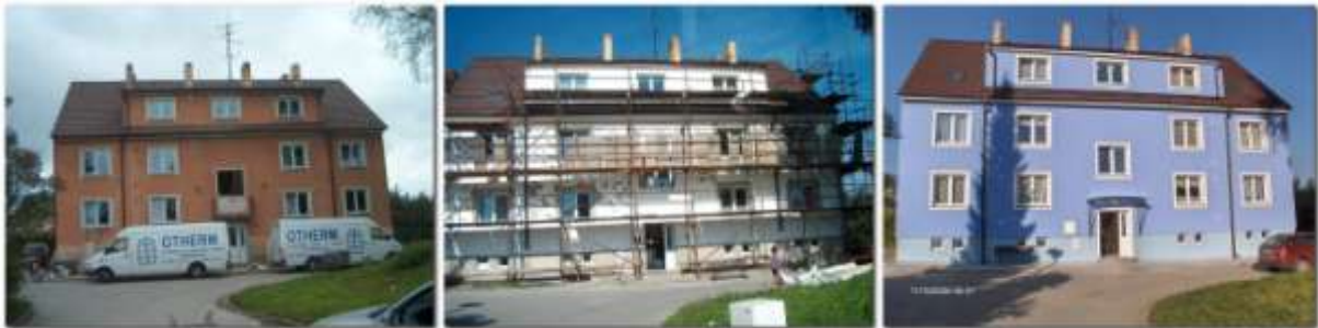
Snímky bytového domu č.25 = 17.5.2005 + 12.8.2005 + 11.10.2005
