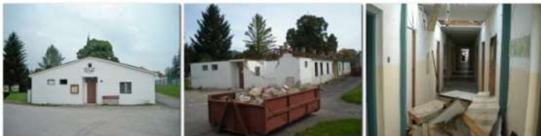
Budova č.70 – Ubytovna z 8.12.2012 + demolice ubytovny – dva snímky z 29.9.2013- F.Z.
