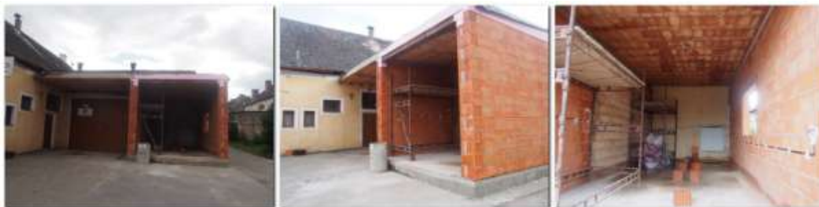
Foto z průběhu výstavby 28.7.2015 – F.Z.
