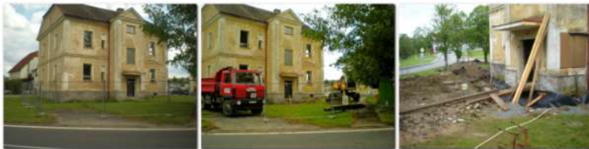
Objekt foto 27.5.2012 + začíná se 3.6.2012 + přípravné rekonstrukční práce 3.6.2012 – F.Z.
