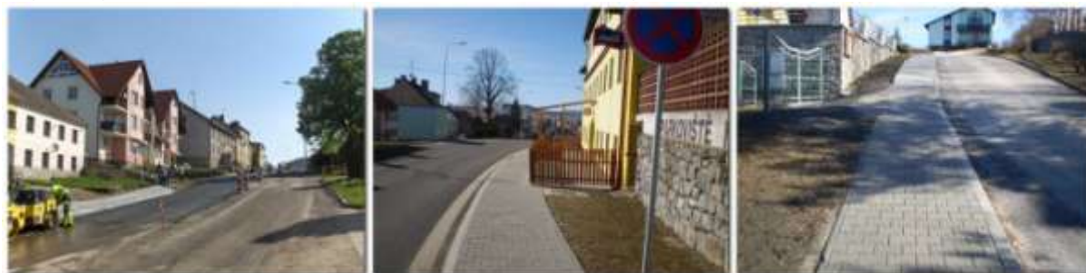
V rámci výstavby silnice ( 21.5.2007) + chodník kolem restaurace U Honzy + chodník za „družstevkami“ – obojí hotovo do konce roku 2007 – foto z 24.2.2008
