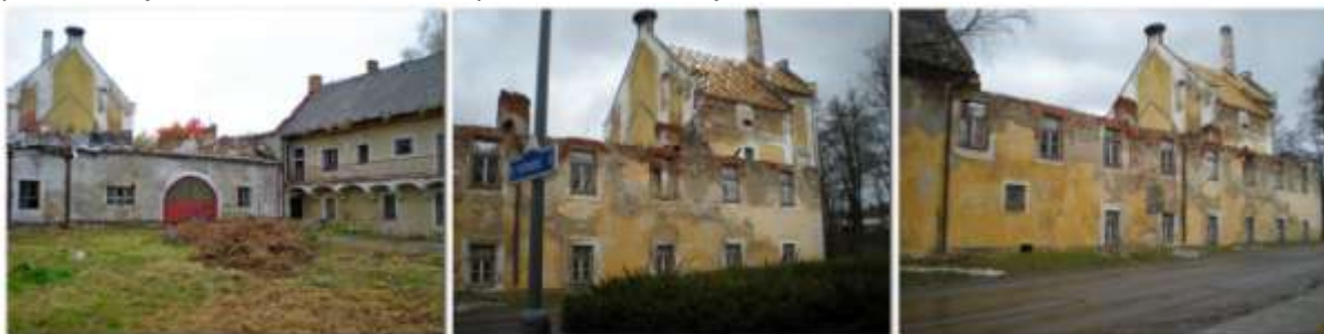
Firma odstranila ohořelé části a začíná stavět nový krov – foto z roku 2013 F.Z.
