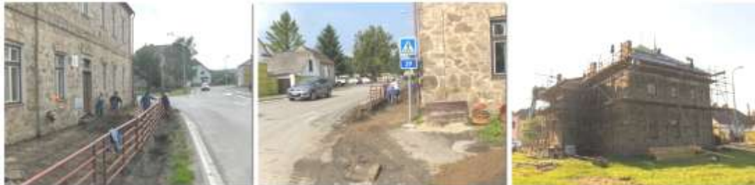
Průběh rekonstrukce Základní školy a chodníku u školy – foto 19. a 20.7.2007
