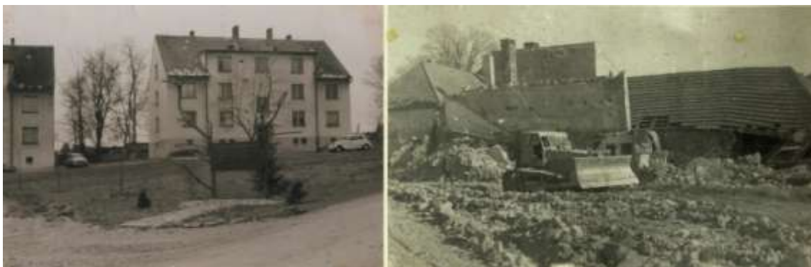
Náves v Bližné roku 1975 + demolice domů č.4 a 5 v r. 1974 – foto archiv kroniky obce
