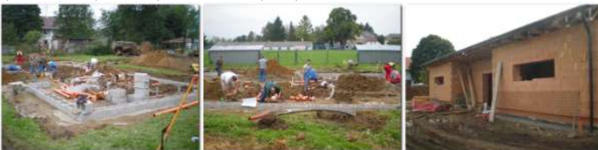
Foto ze staveniště 4.9.2012 – první a druhý snímek + 24.9.2012 – F.Z-
