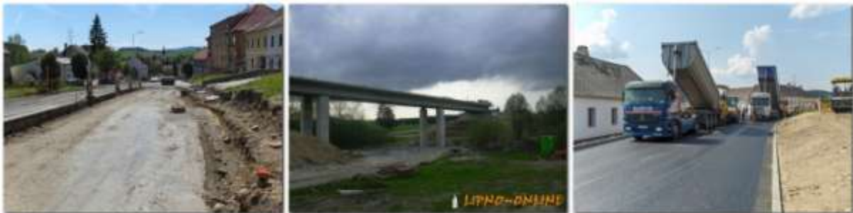
Výstavba silnice přes obec, stavba mostu ve směru na Mokrou a poslední fáze výstavby – rok 2007
