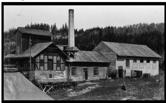
Stará šachta na Mokré
