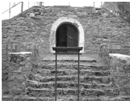
V prostoru autokempu Na terasách vidíme zachovalý bunkr
