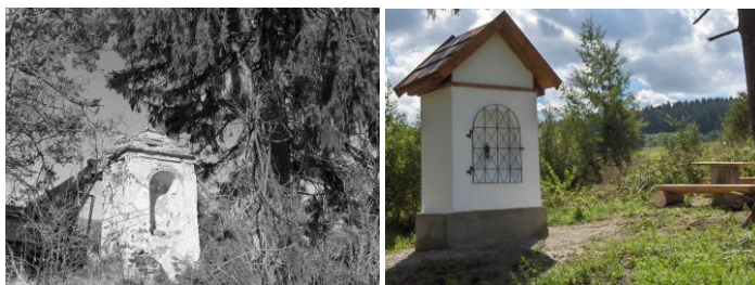
Na obr. je kaplička na Hubenově před a po opravě
