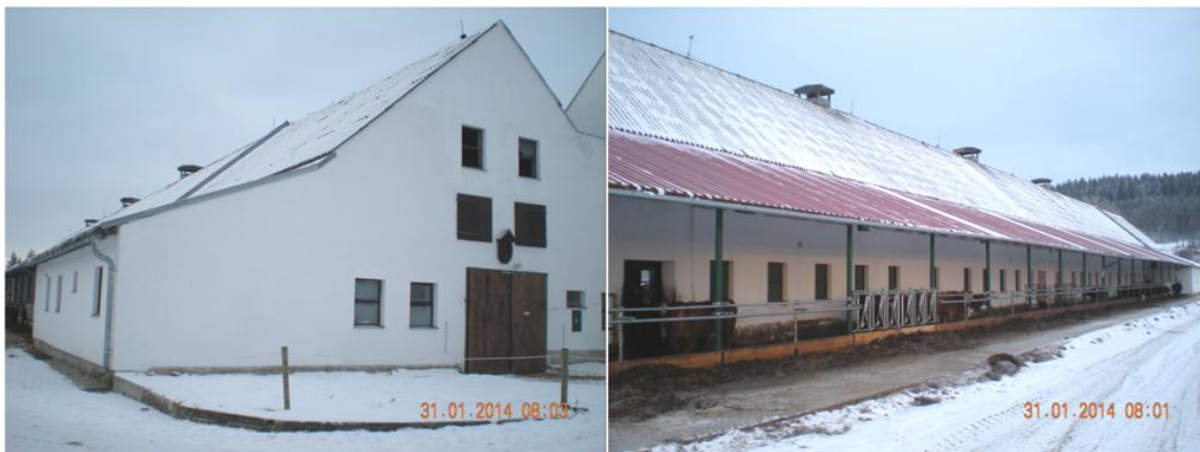
Stáj Kravín Muckov 2 byl osmou zrekonstruovanou stájí celého komplexu staveb pro potřebu živočišné výroby
