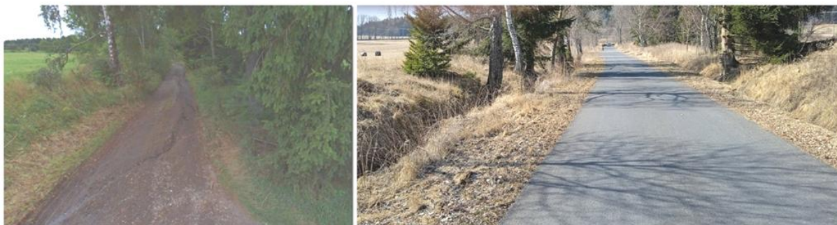
Snímek cesty mezi Žlábkem a Olšovem z Google Earth + nový povrch – foto 20. 3. 2022 F.Z.
