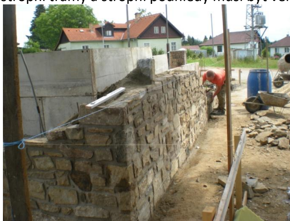
Stručně fotoprůběh výstavby – 8. 7. 2014
