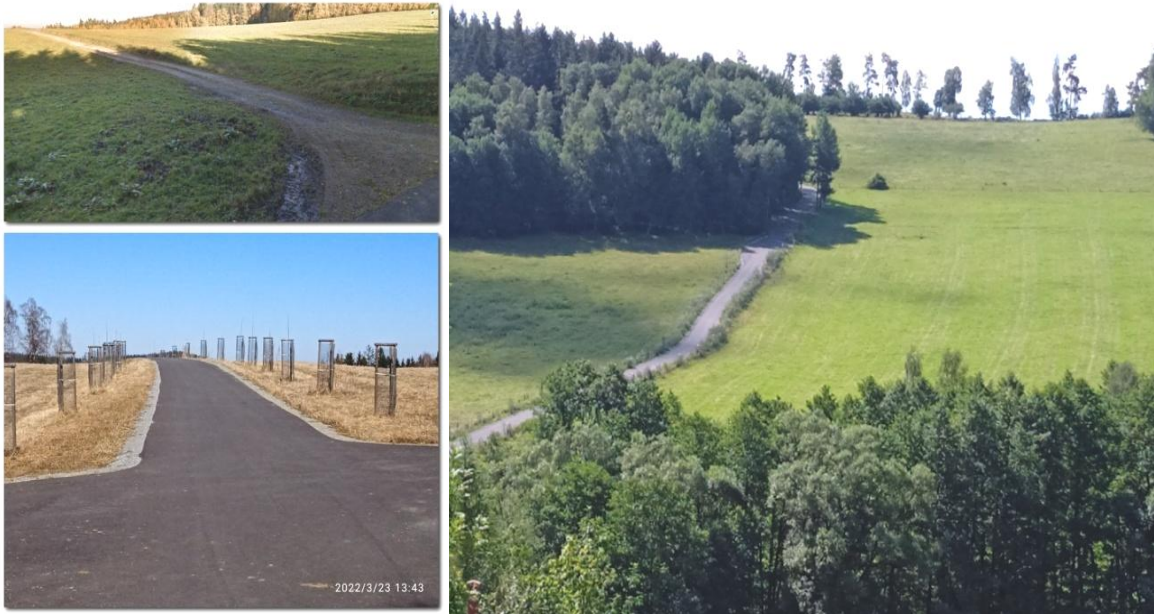
Rekonstruovaná polní cesta na Všímary - Horní Dlouhá – foto staré cesty / mapy Google/ + nová 23. 3. 2022 + vpravo asfaltová cesta přes pastevní areál Všímary – 15. 7. 2022 – F.Z.
