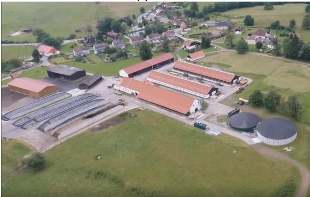
Bioplynová stanice zasazená v areálu farmy – foto z dronu 2016
