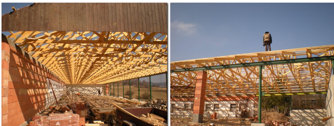
Téměř úchvatně vypadala stavba krovu na stáji teletník – foto 3. 4. 2011 - F.Z.
