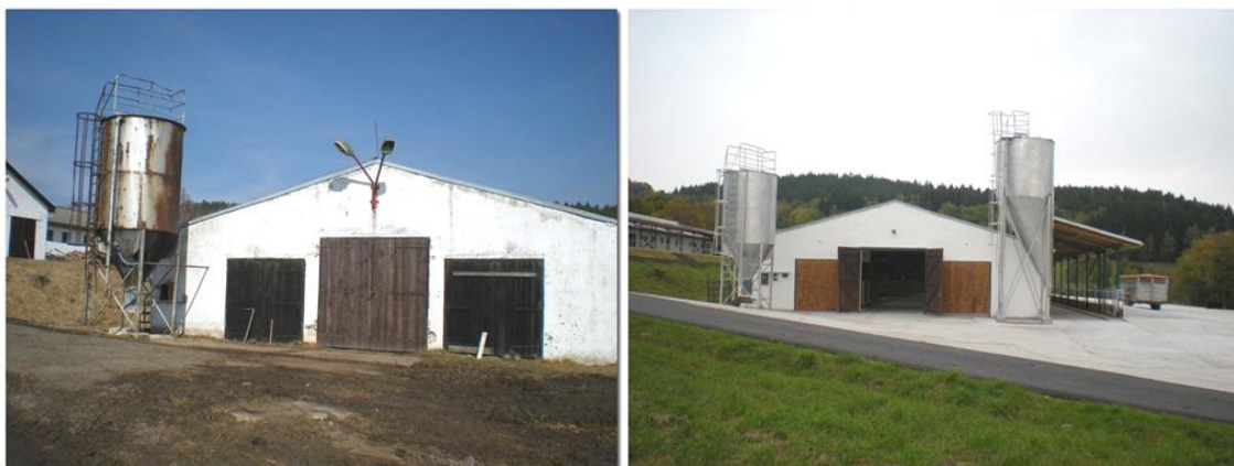
Odchovna Ostrov : před – foto 23. 3. 2010 – F.Z. po rekonstrukci – 16. 11. 2011 – F.Z.
